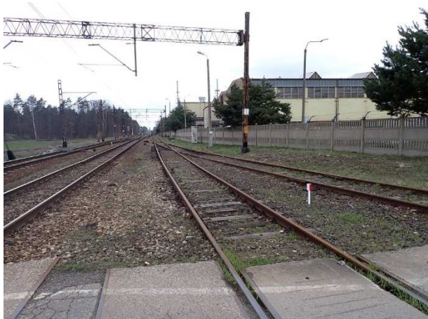
Fot. 9. Widok z ul. Techników w kierunku północnym wzdłuż torów kolejowych.
