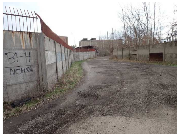
Fot. 10. Widok na zabudowę fabryki wentylatorów Fawent.
