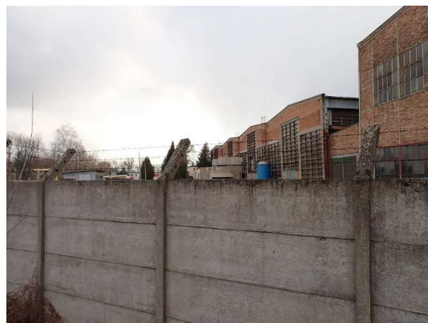
Fot. 11. Widok na zabudowę fabryki wentylatorów Fawent.
