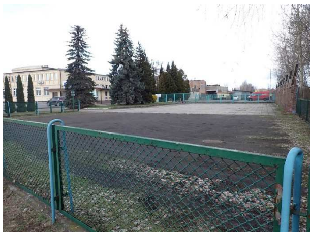
Fot. 8. Widok na zabudowę fabryki wentylatorów Fawent.
