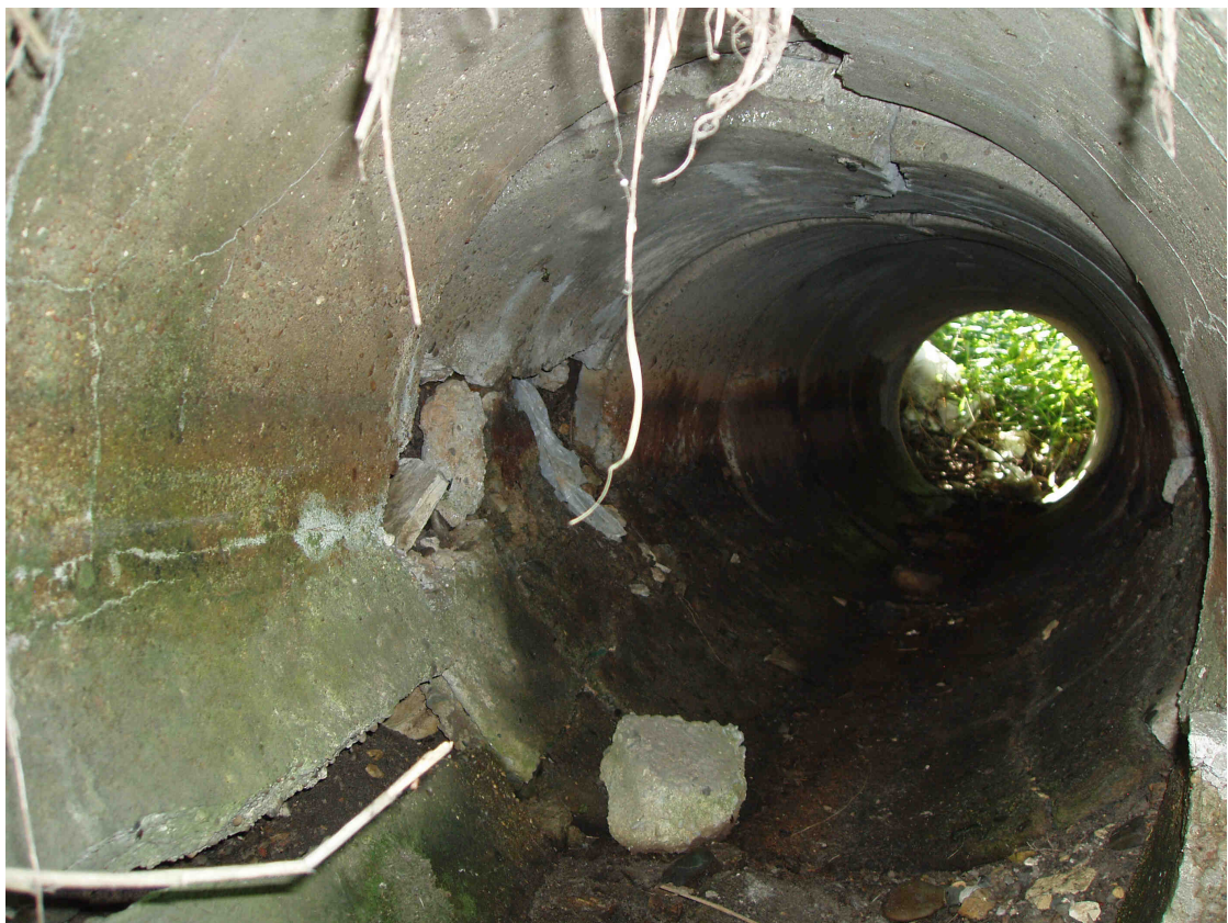
Fot. 4. Widok na spękane, złuszczone i pokruszone rury przepustowe
