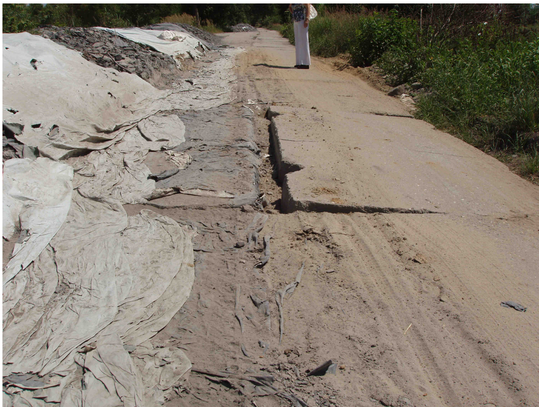
Fot. 2. Uszkodzenia nawierzchni. Rozsunięcia i spękania płyt
