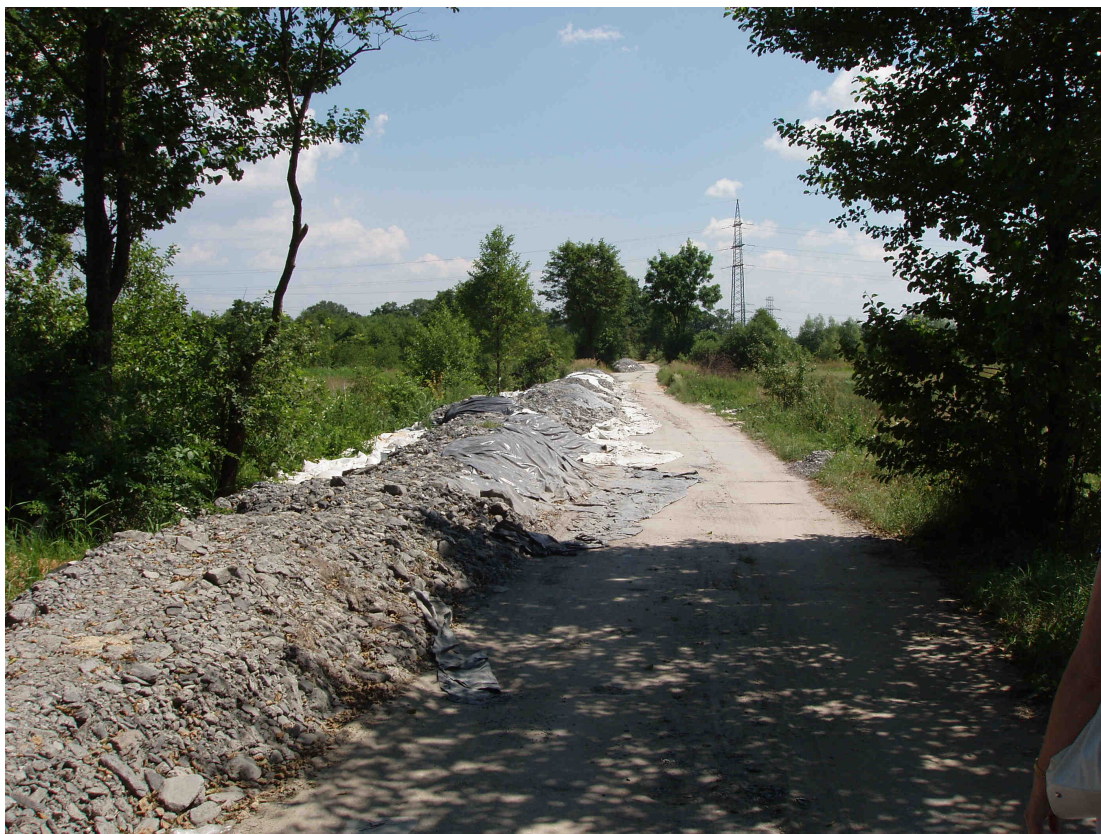
Fot. 1. Widok na pozostałości po zabezpieczeniach przeciwpowodziowych
