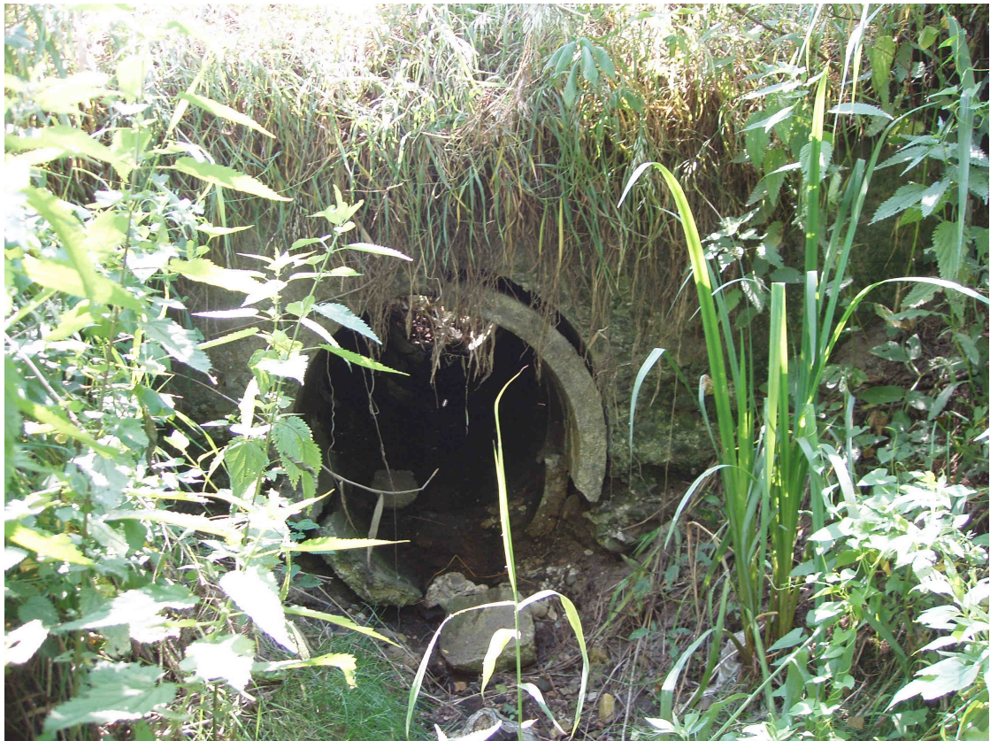
Fot. 3. Widok na zdegradowaną ściankę czołową przepustu
