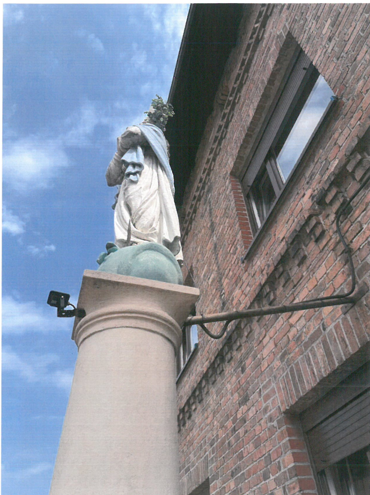
Zdj. 6. Widok na fragment kapliczki oraz sąsiadujący budynek. Kapliczka wspiera na metalowym wsporniku. Na zdjęciu widoczne są instalacje elektryczne, 2024.
