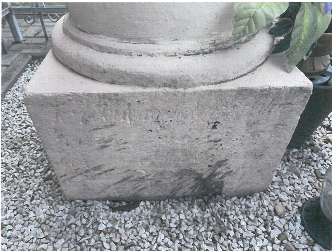
Zdj. 9. Widok na cokół kolumny z grubą warstwą przemalowań oraz nieczytelną inskrypcję, 2024.
