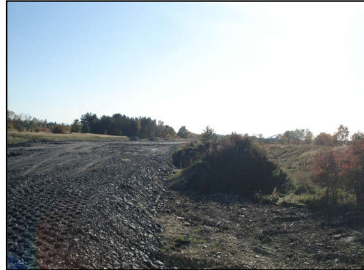
Fot. 11 Budowa wałów przeciwpowodziowych w dolinie Przemszy.
