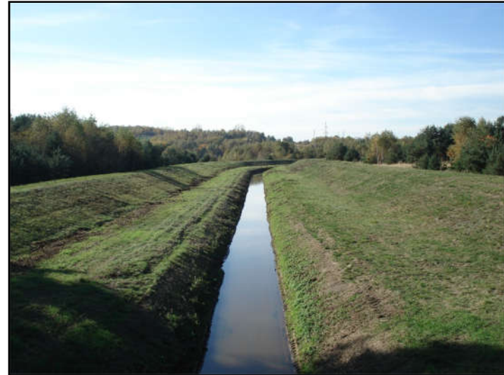
Fot. 12 Nowe koryto Imielinki, widok z ul. E. Romera.
