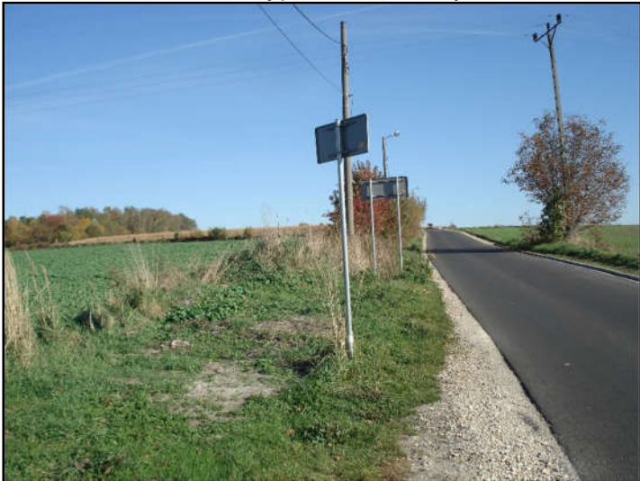
Fot. 2 Ul. K. Kurpińskiego i Smutna Góra widziana od strony południowo-wschodniej.
