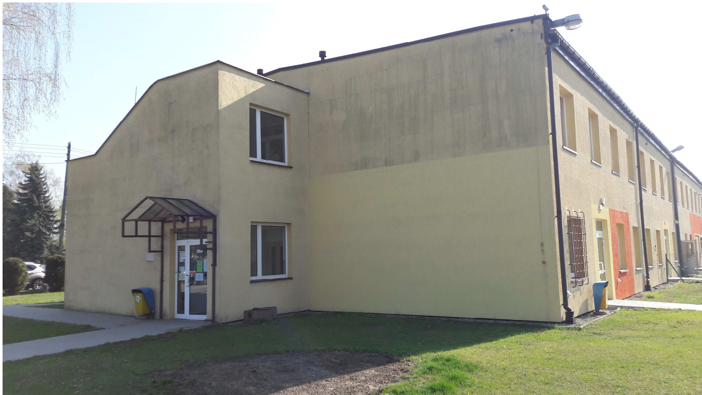
WIDOK NA ELEWACJĘ ZACHODNIĄ
