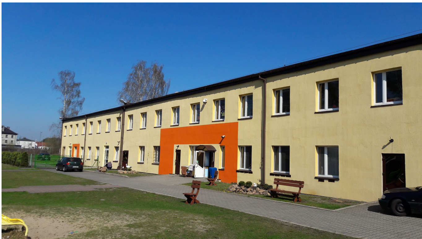
WIDOK NA ELEWACJĘ POŁUDNIOWĄ
