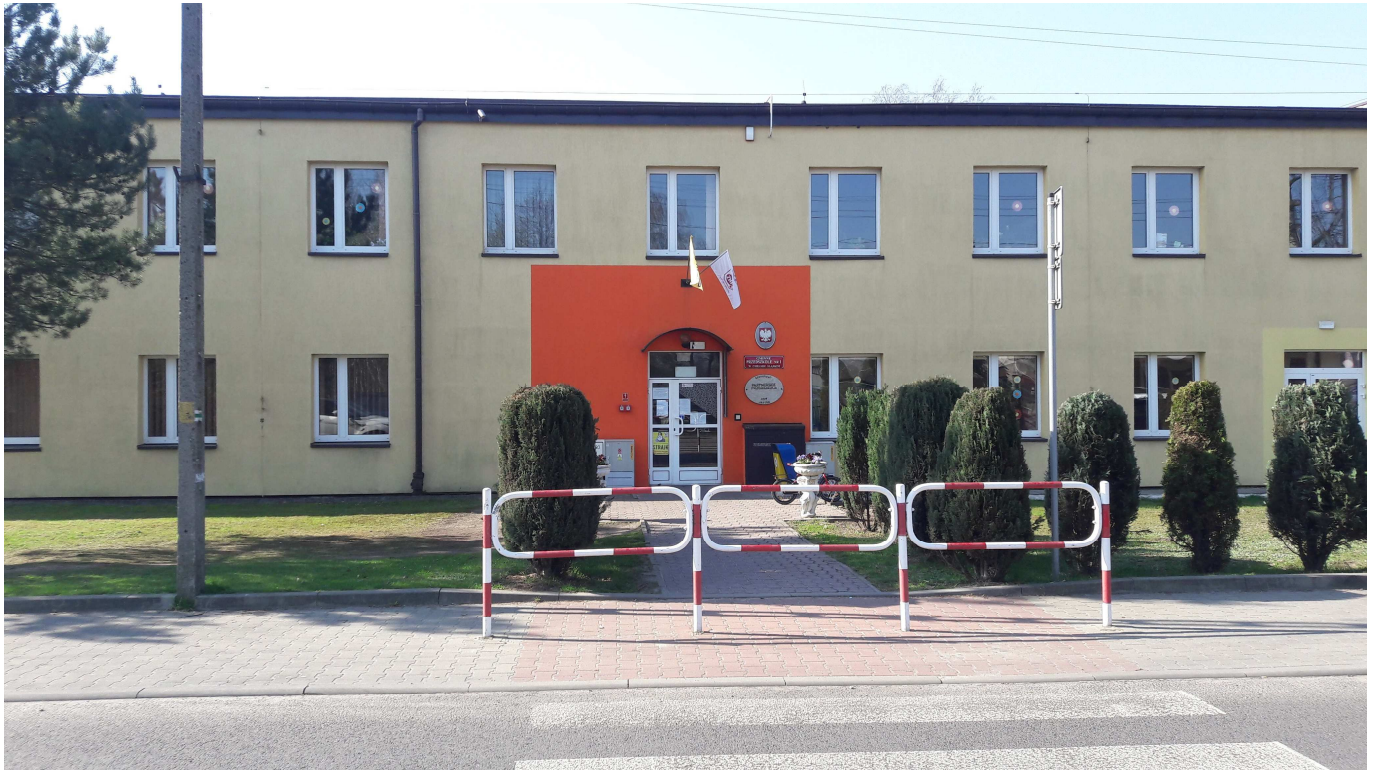
WIDOK NA ELEWACJĘ PÓŁNOCNĄ
